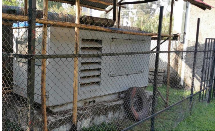
Olaf har reparert generatoren
